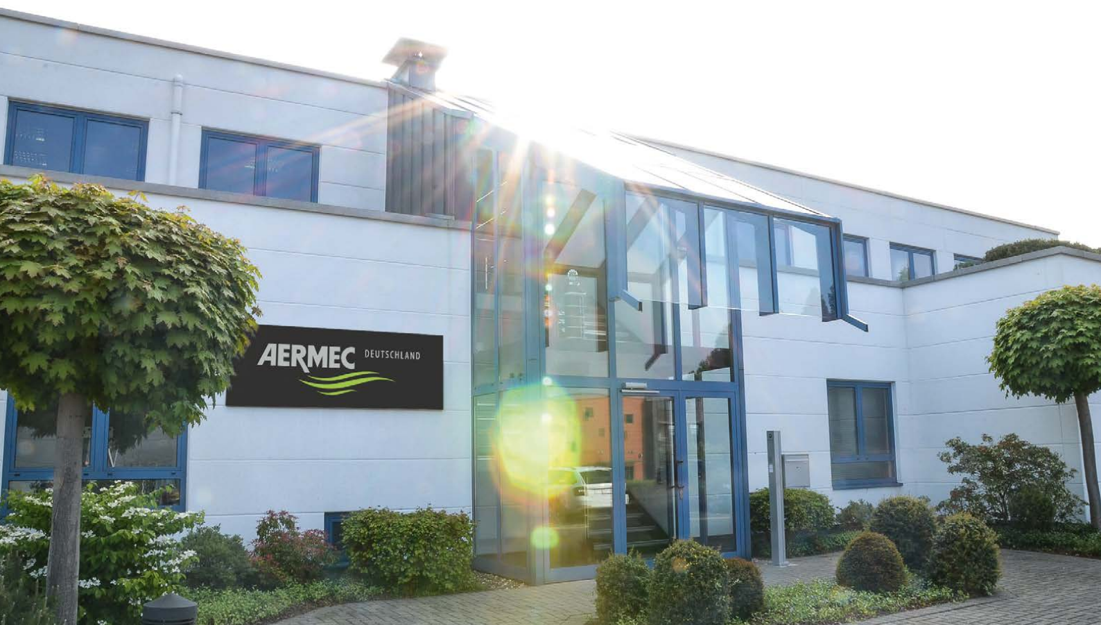
Zentrale AERMEC Deutschland, Ratingen
